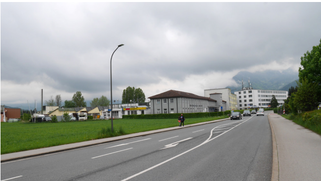
Abb. 27: Vorbelastung | B 305 - Bahnhofstraße
